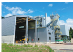
矢巾バイオマス発電所
